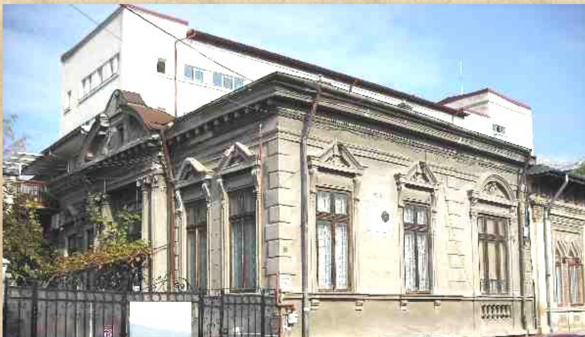
Casa lui Marin Sorescu, str. Grigore Alexandrescu nr. 43, București, cu placa comemorativă de marmură montată pe fațadă
