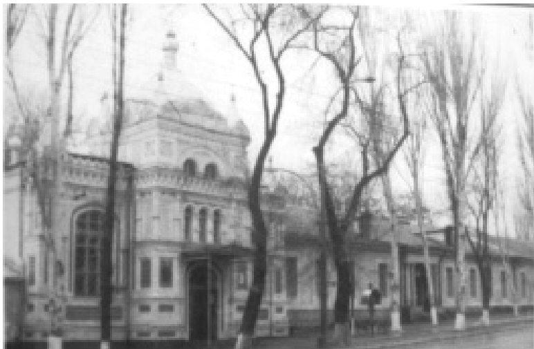
Aspectul Spitalului orașenesc din Chișinău
