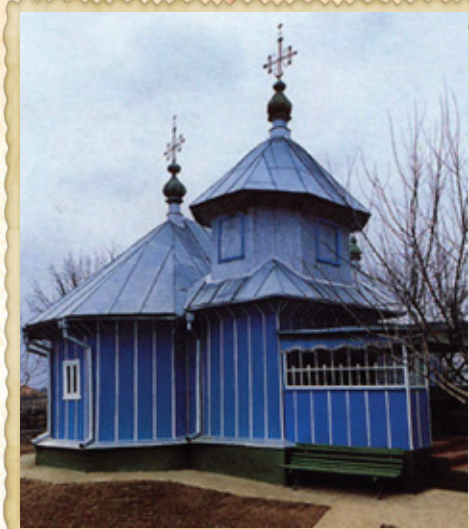
2000. Biserica din lemn cu hramul Sf. Nicolae din satul Heciul Vechi, raionul Singerei. Anul construcției 1791. Imagine N. Rotaru.
