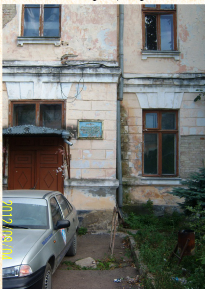
Scara administrației DECM (KEЧ), privită din spatele edificiului.
