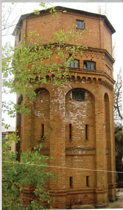
Castelul de apă de pe teritoriul stației feroviare Drochia (astfel arăta și cel de la Bălți pînă la demolare).
