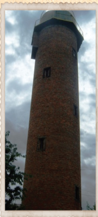
Castelul de apă de la SA „Floarea Soarelui” (1960)
