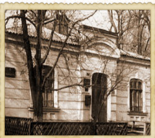
Bălți. Str. Independenței. Vis-a-vis de Biblioteca Științifică USARB. Stația de transmisiune radio (clădirea a fost demolată). Imagine internet.
