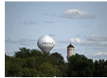
Vechiul și noul castel de apă din Nicollet, Minnesota (S.U.A.)
