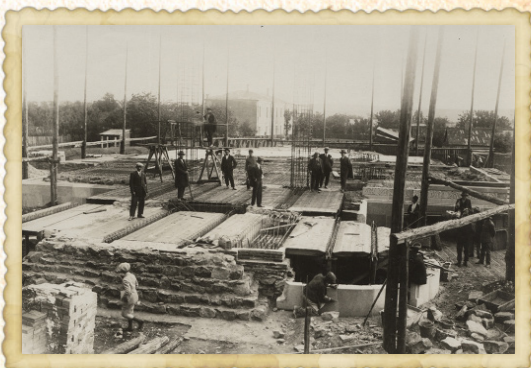
Lucrările de construcție a temeliei Catedralei „Sf. Împărați Constantin și Elena” din Bălți. Imagine de C. Tomescu.
