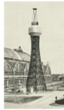
Construcție de V. Șuhov. Prima structură hiperboloidă din lume (Rusia, 1896)
