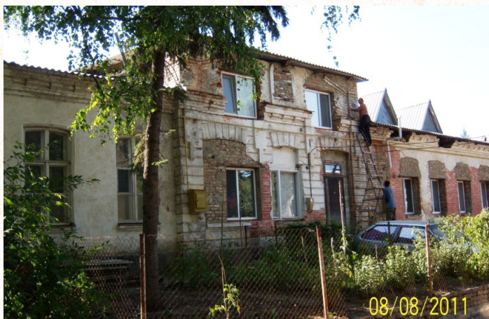
Bălți. Statul major. Complexul militar din str. A. Lăpușneanu, 10A.
