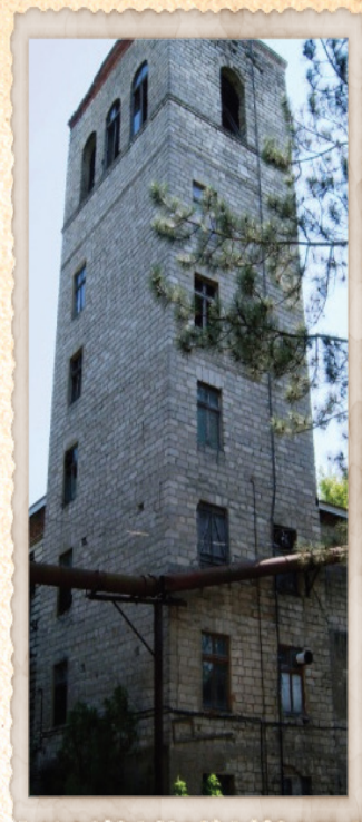
Castelul de apă de la SA „Mioara” (1955)
