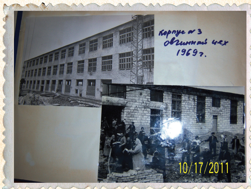
Bălți. Construcția blocului nr. III. Secția de prelucrare a pielii de oi. 1969. Imagine din arhiva SA „Mioara”.
