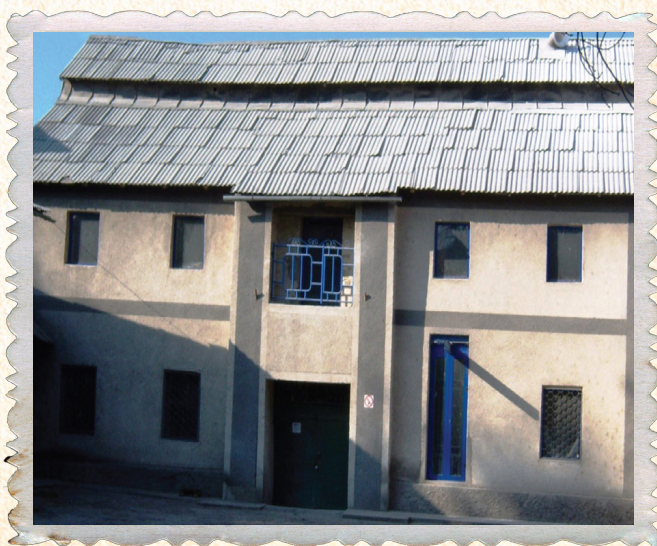
Bălți. Moara nr. 5 din str. Ștefan cel Mare. Imagine actuală.
