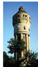
Castel de apă dezafectat, cart. Iosefin, Timișoara (România)
