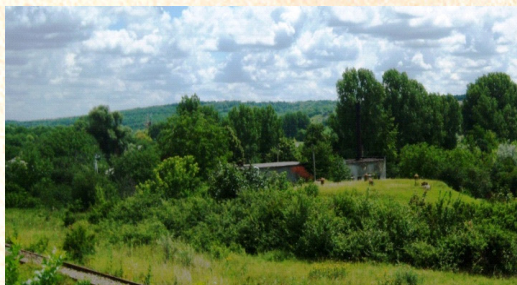
Rezervuarul stației de pompare.
