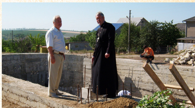
2012. Bălți. Sectorul Bălțiul Nou. Protoiereul mitrofor Pavel Gorea și arhitectorul șef Boris Grițunic verifică de pe șantier.
