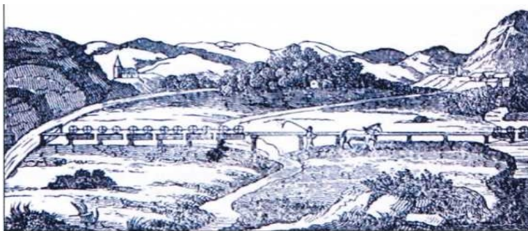
Fig. 1 a. Vedere generală a unei porțiuni din monoraiul suspendat al lui Palmer. Se disting 6 cărucioare-vagonete, fiecare cu câte două roți de care sunt atârname benele de transport materiale. Se observă și motorizarea de tip monocabalin.
